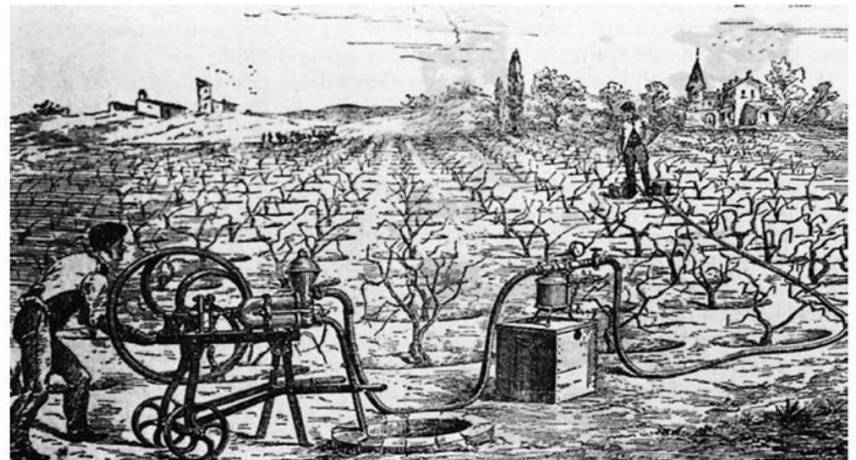
Figura 3. Tratamiento de una viña con sulfuro de carbono mezclado con agua mediante una bomba a presión de tipo manual (Año 1895).
